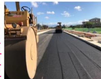
桃園市道路改善工程施工情形 (桃園市政府新建工程處提供)
